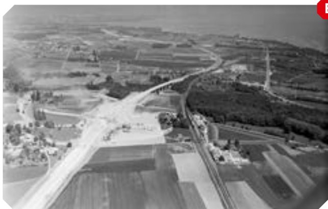
CONSTRUCTION DE L'AUTOROUTE GENÈVE-LAUSANNE. 1963.
