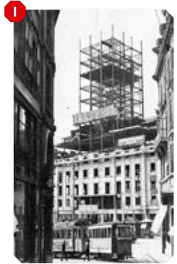
CONSTRUCTION DE LA TOUR BEL AIR. Lausanne (VD), 1930.
