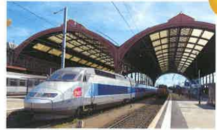
Le TGV Est en gare de Strasbourg.
